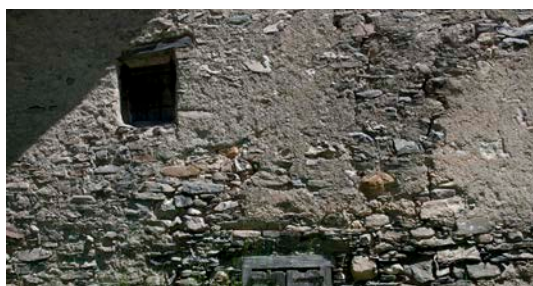
Mur à l'état brut
