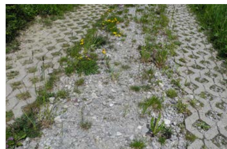
Les dalles alvéolées permettent de construire un chemin en dur tout en laissant l'eau de pluie s'infiltrer dans le sol.
