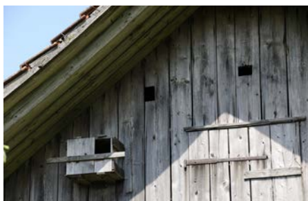
Le faucon crécerelle peut utiliser le nichoir installé sur la façade extérieure ou celui installé sur la paroi intérieure (seul l'orifice est visible).
